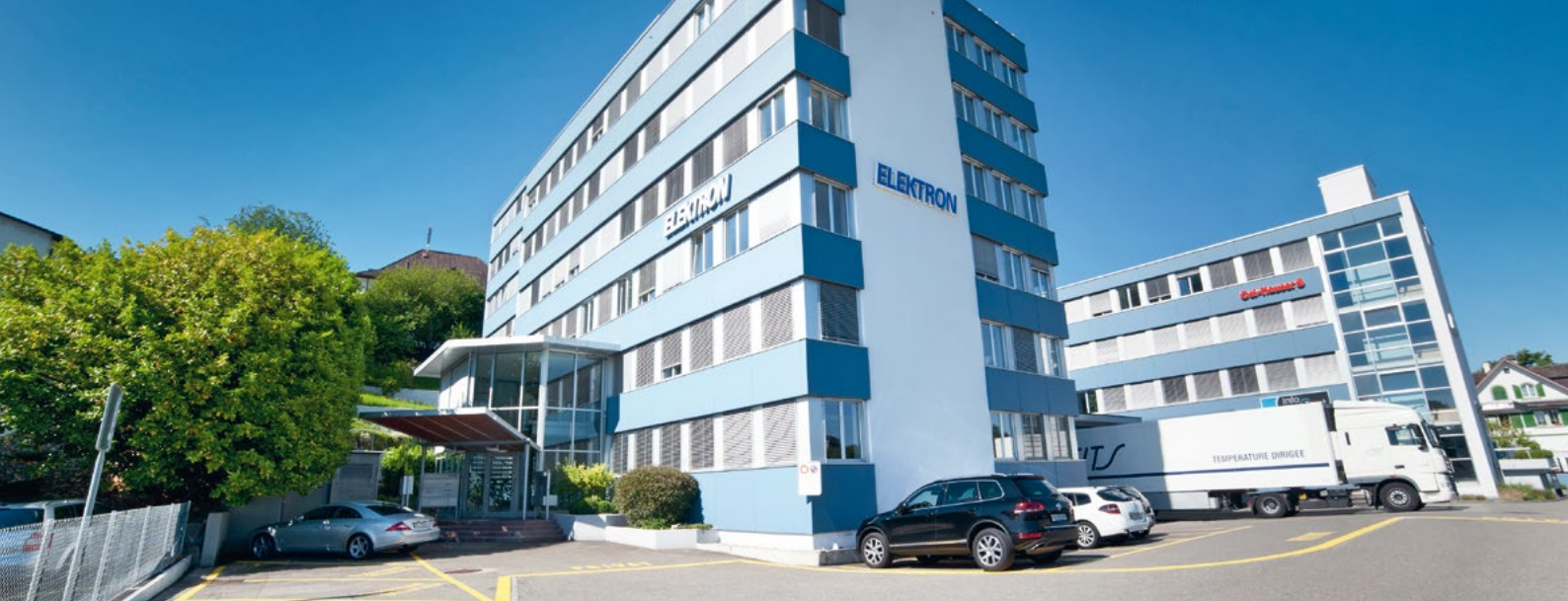
Gebäude der Elektron AG an der Riethofstrasse 11 in Au/Wädenswil
